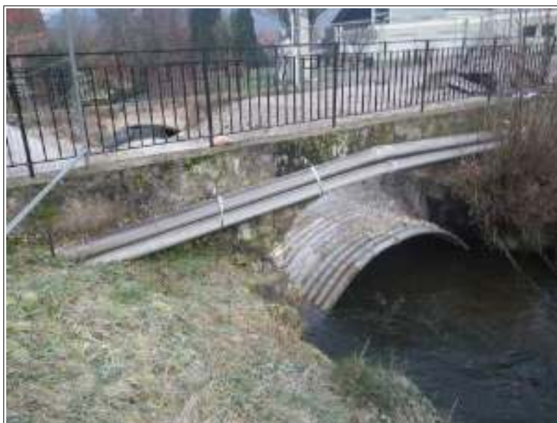
Vue de l'ouvrage existant après excavation des débris d'enrobé
